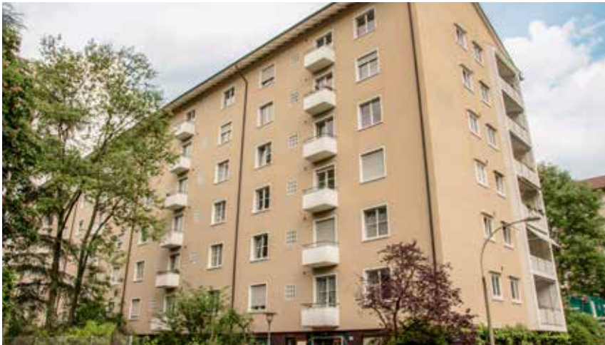
Die Siedlungen der Wohngenossenschaft Kannenfeld stammen aus der Nachkriegszeit.
