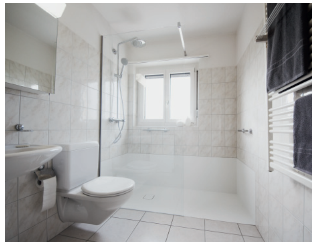
Situation nach dem sanften Badumbau: Hochwertiges, fugen- und schwellenloses «purity»-Duschvergnügen aus Corian.
